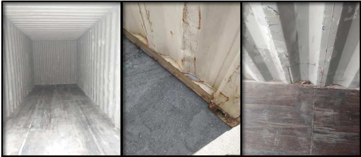
貨櫃內部櫃況檢查，檢查是否須油漆、有無破損，右上為貨櫃修補過的痕跡
