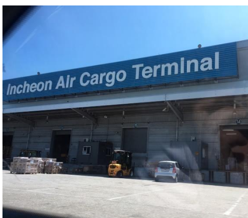
圖五 仁川國際機場空運貨物航廈
