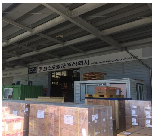
圖七 COSMO Airfreight Consolidators 空運貨物物流中心
