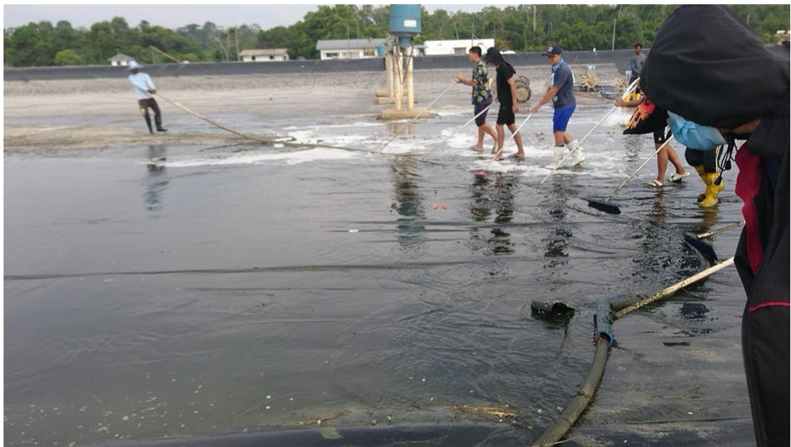
整池作業，以水管來推動汙泥，避免汙泥回流
